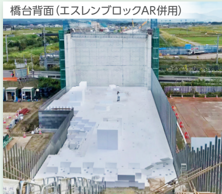
道路高上げボックス保護(エスレンブロックAR併用)
